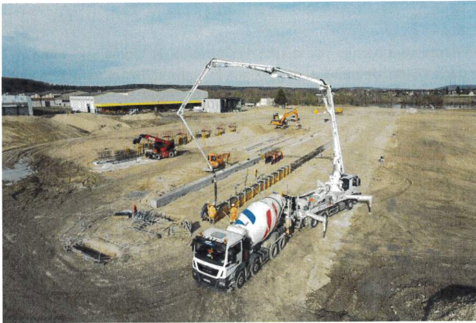
La future plateforme multimodale de Val d'Hazey s'installe sur un site de 13 ha en bord de Seine. © Carrières de Vignat
